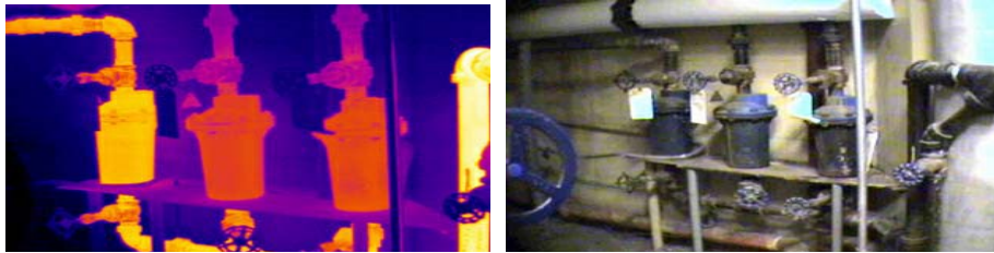
شکل ۱۵- بررسی وضعیت عملکرد والوها و تله‌های بخار (سمت راست: تصویر معمولی-سمت چپ: تصویر ترموویژن)
