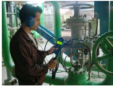
شکل ۷- بررسی وجود نشتی هوا از اتصالات نیوماتیکی یک کنترل والو
