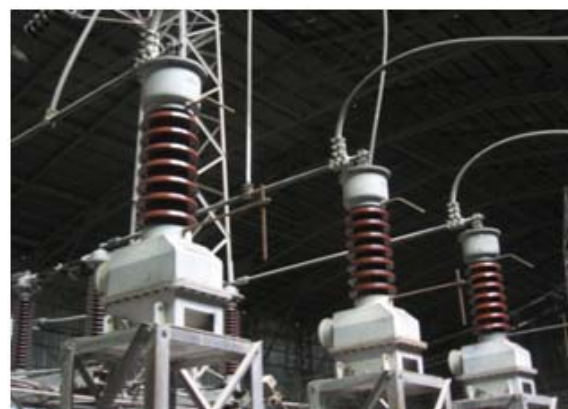
شکل ۱- کلمپ رابط فاز وسط خط ۶۳۳- تصویر واقعی
